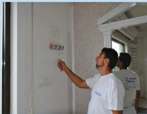
Nanošenje akrilne podloge
